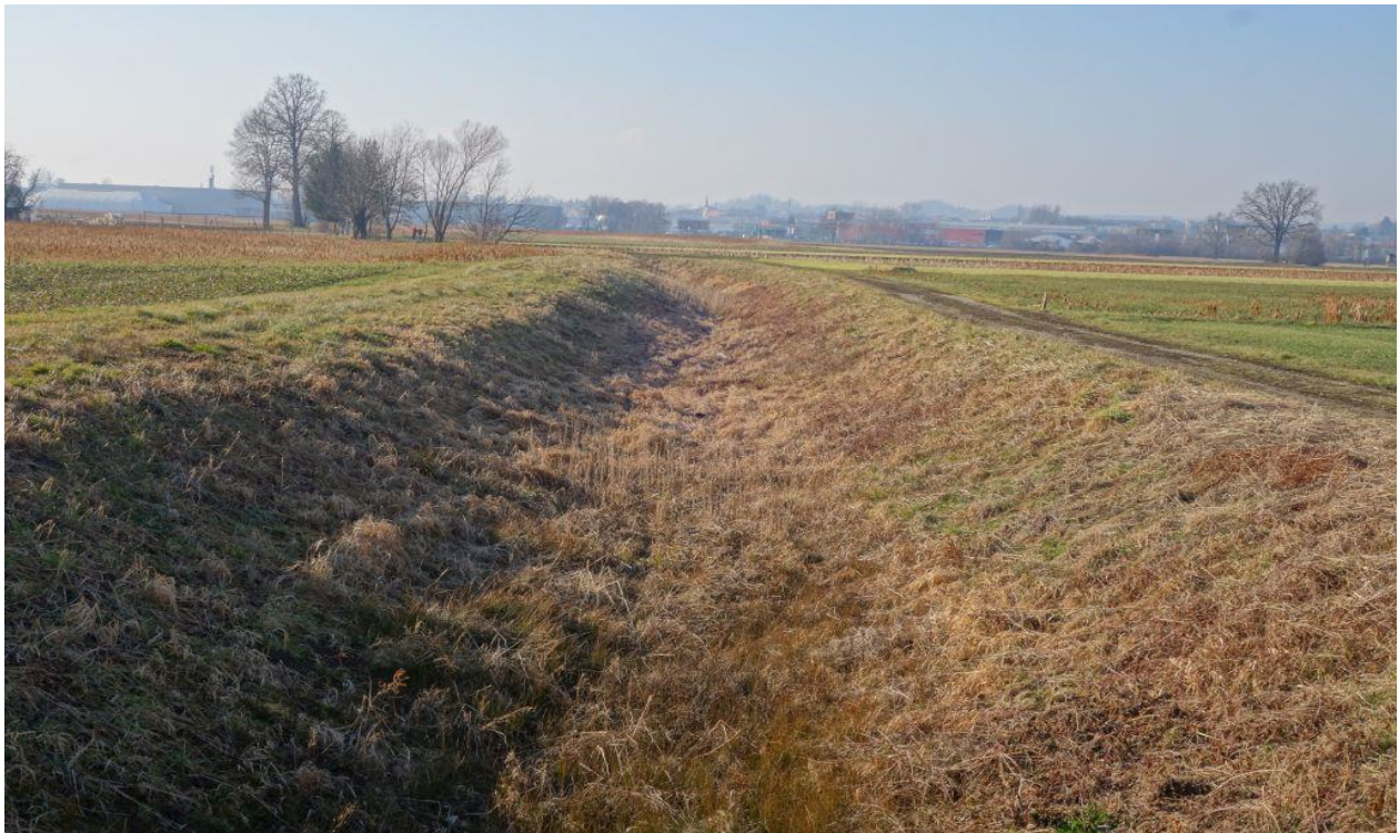
Slika 11. Kanal meteornih vod, ki se izliva v vodotok Rogoznica
