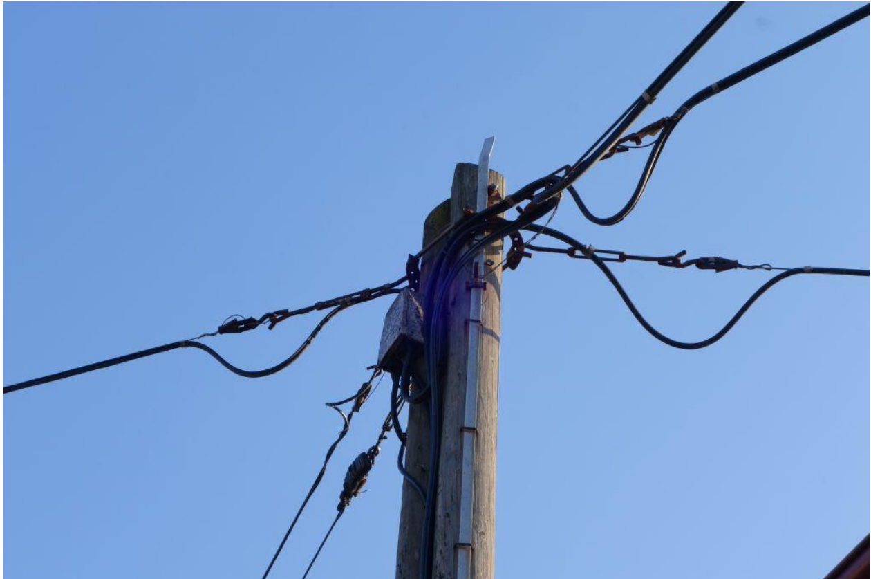
Slika 7. Prepleteni kabli telefonije, ki jih lahko zasledimo po celotni ČS Jezero
